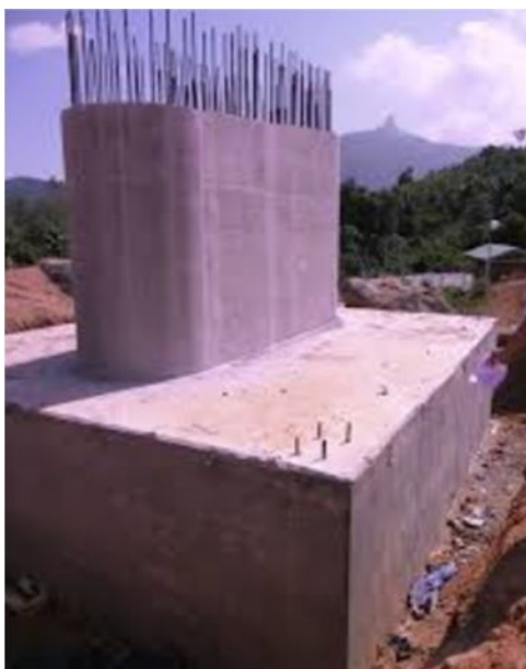
Рис. 1. Строительство массивной мостовой опоры во Вьетнаме
